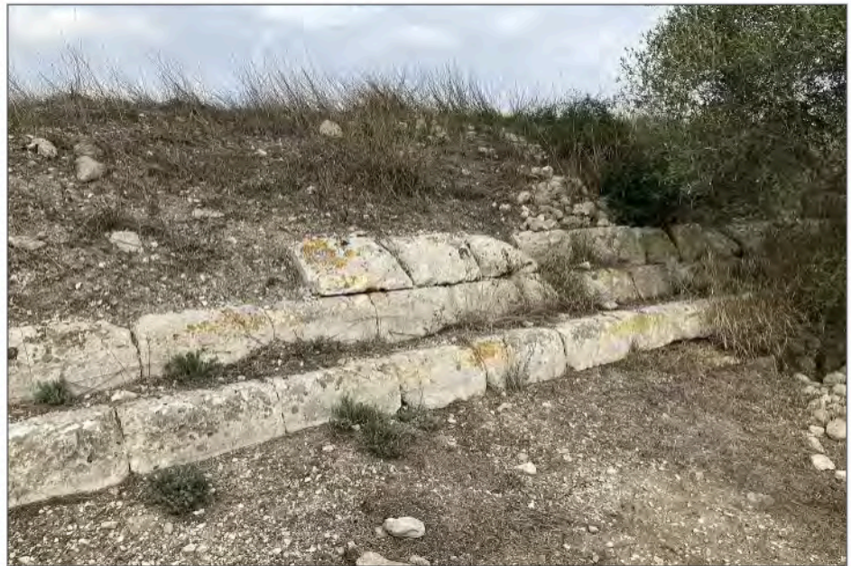
53. - Castellana, località Minerva. Setto murario visibile lungo il perimetro del pianoro.
