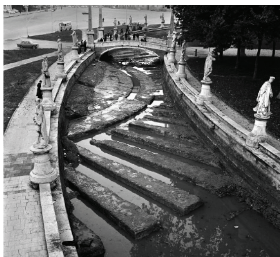
Quanto rimane dello Zairo in una foto d'epoca. Gli ultimi scavi per mettere in luce la struttura furono eseguiti nel 1962 e nel 1983 ( www.lavecchiapadova.it )
