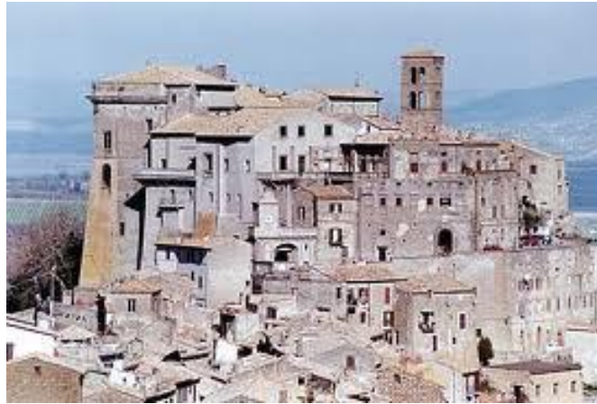
Bomarzo: vista della rocca medioevale col palazzo Orsini e la torre campanaria
